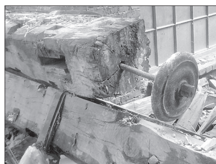
Rys. 8. Szczegół kotwy łączącej drewniany podciąg z mурowym filarem
