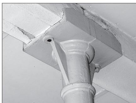
Rys. 7. Żeliwna głowica słupa
