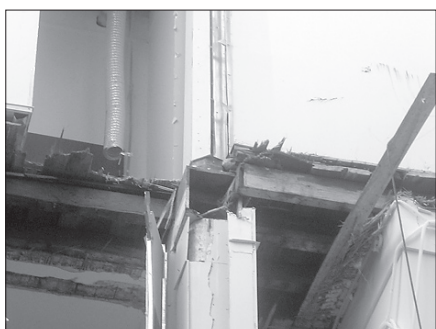
Rys. 6. Żeliwna skrzynka do oparcia drewnianego podciągu na słupie
