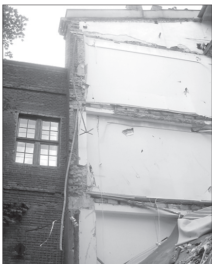
Rys. 12. Kotwy z płaskownika w płaszczyźnie ściany
