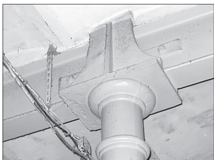
Rys. 10. Oparcie stalowego podciągu na żeliwnym słupie
