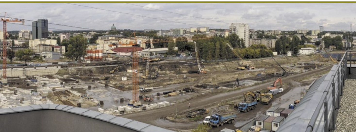
Fot. 1. Wykop pod nowy dworzec Łódź Fabryczna.
