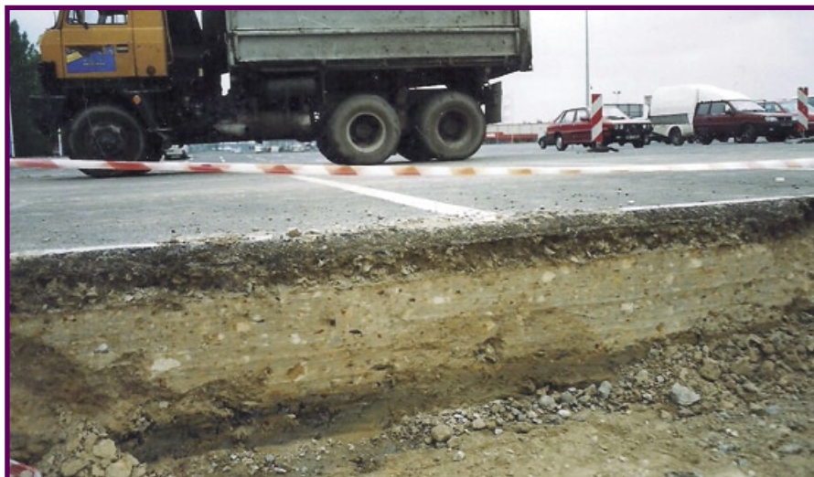
Fot. 5. Przekrój nawierzchni z widoczną zastabilizowaną warstwą stanowiącą barierę dla podciągania kapilarnej wody gruntowej
