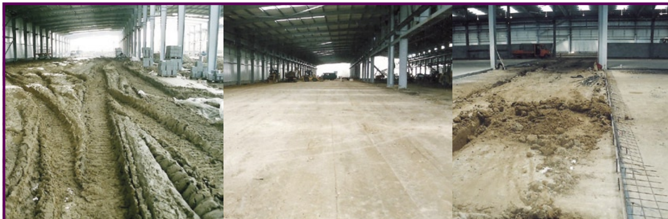
Fot. 4. Hala fabryczna „Martifer” w Gliwicach (2003/2004 r.) Stabilizacja w technologii „envtech” gruntu gliniastego pod posadzkę betonową
