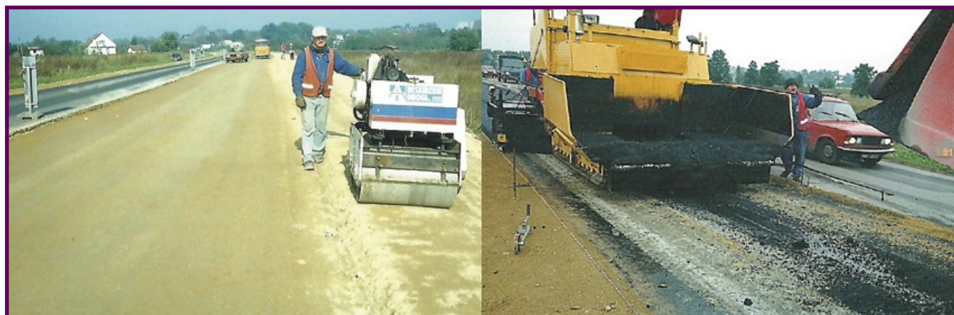
Fot. 2. DK44 (2001 r.) Zagęszczanie zastabilizowanego gruntu pobocza i rozścielanie emulsji asfaltowej na zastabilizowanej warstwie gruntowej podbudowy bezpośrednio pod warstwę betonu asfaltowego
