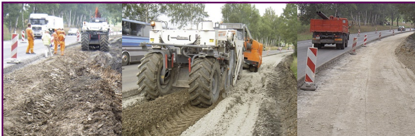
Fot. 3. DK94 (2007 r.) Jednodniowy efekt stabilizacji podłoża gliniastego cementem + EN-1, warstwa 35 cm
