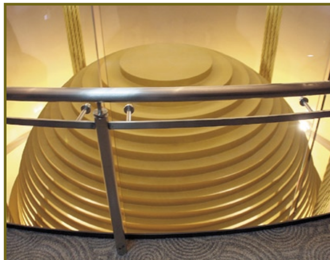
Fot. 2. Masa tłumika sejsmicznego wieżowca w Taipei, masa 680 ton
