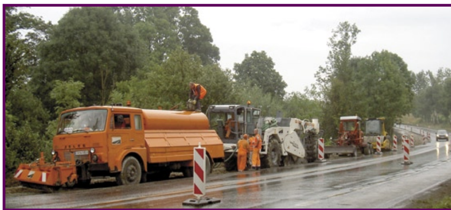
Fot. 1. Sprzęt do stabilizacji podczas wzmacniania gruntu gliniastego skrajnego pasa drogi krajowej z użyciem cementu i środka EN-1: cysterna, recyler, równiarka, walec, (rozścielacz do cementu jest niewidoczny)
