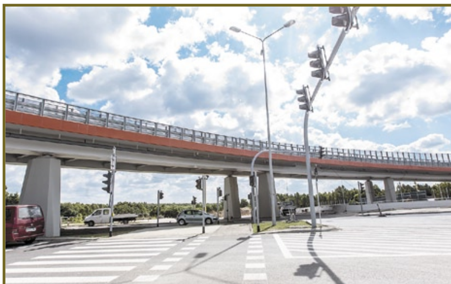
Fot. 3. WD-7 estakada w ciągu łącznicy węzła przy ul. Rzgowskiej w km 4+309,617
