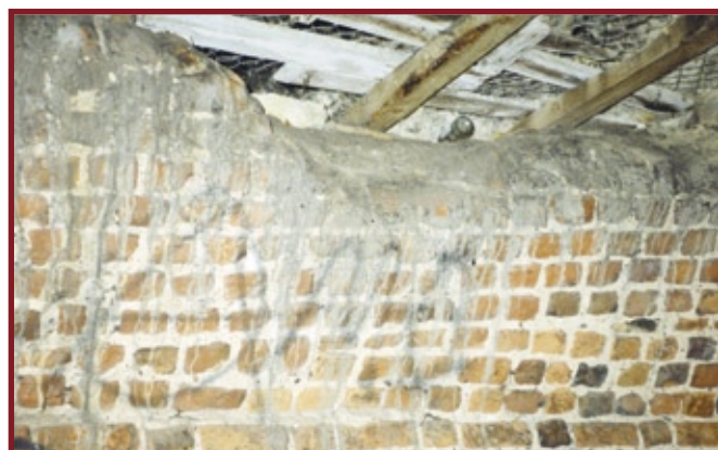
Fot. 2. Ściana północno-wschodnia, widok od wewnątrz z fragmentem dolnego sklepienia
