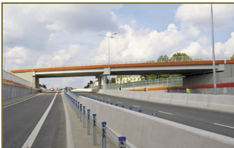
Fot. 4. WD-2, wiadukt drogowy w ciągu łącznicy ul. Śląskiej w km 0+847,69
