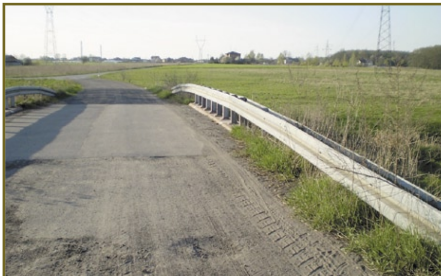
Fot. 2. Odnowienie obiektu przed remontem drogi
