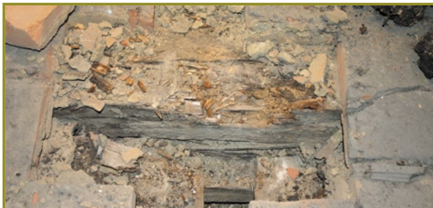
Fot. 2. Odkrywka stropu nad ostatnią kondygnacją skrzydła zachodniego. Widoczne elementy ceramicznej podłogi
