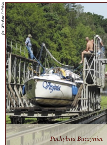
Urządzenia techniczne Kanału Ostródzko-Elbląskiego
