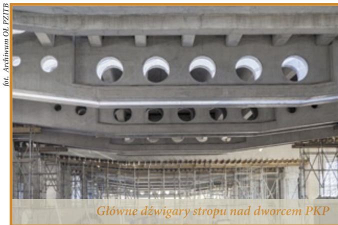
Główna konstrukcja monolityczna i prefabrykowana dworca PKP w obszarze środkowego świetlika
