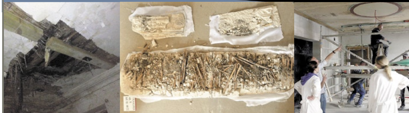
Ryc. górna: wizualizacja obiektu wykonana przez pracownię RWSL w trakcie prac projektowych. Poniżej: stan stropu (fot. z lewej), odkrywki pobrane do badań (fot. pośrodku), transfer polichromii (fot. z prawej)
