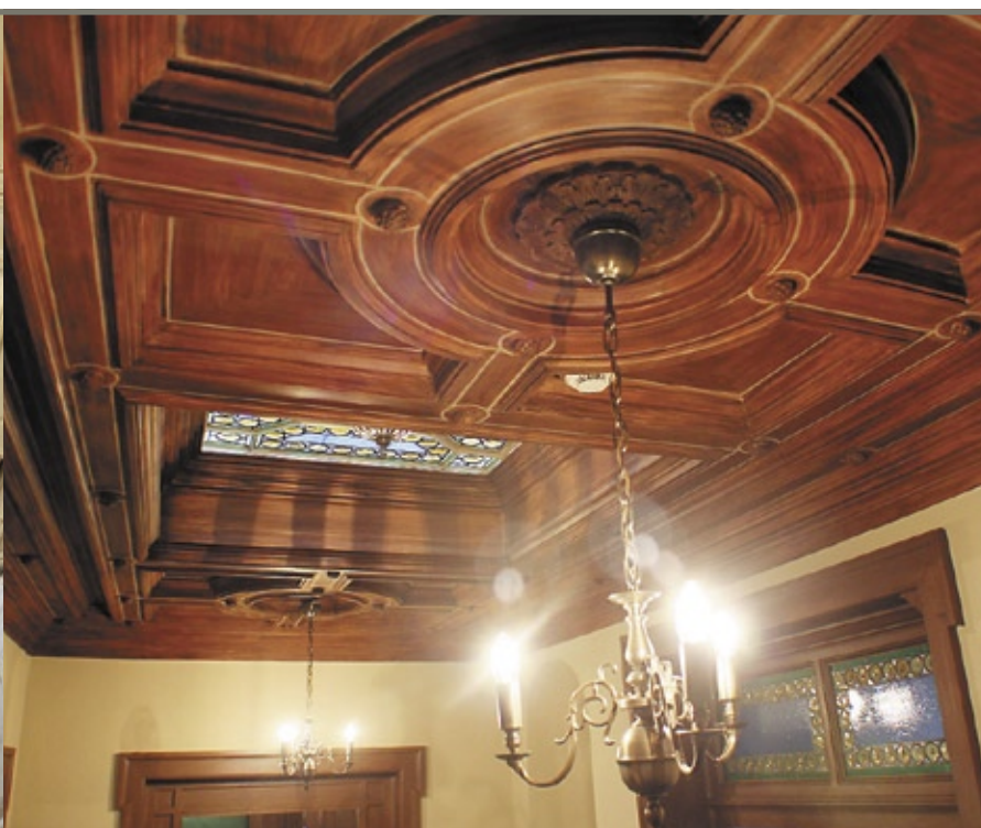
Sufit gipsowy mazerowany westybulu
