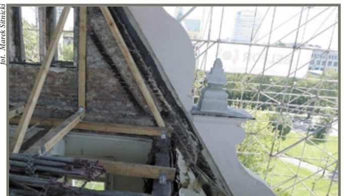
Fot. 4. Konstrukcja stabilizująca ściany szczytowe, widoczny „śląd” dawnego dachu – kwiecień 2017 r.
