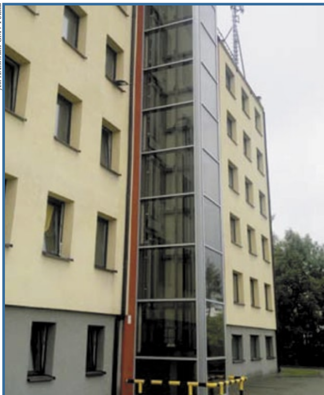
Fot. 8. Pięciopiętrowy budynek w Cieszynie z dobudowanym dźwigiem zewnętrznym
