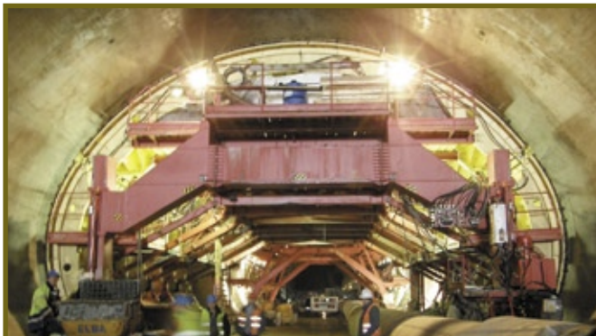
Ryc. 21. Przejezdny zestaw szalunkowy. Betonowanie obudowy docelowej
