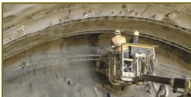
Ryc. 18. Montaż obudowy tymczasowej kaloty. Mocowanie krążyn, układanie siatek zbrojenia i następnie narzut 20 cm betonu. I tak kolejno co 60 cm.
