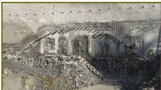
Ryc. 16. Zarys otworu wyznaczony przez parasol z kotew osadzonych w górotworze
