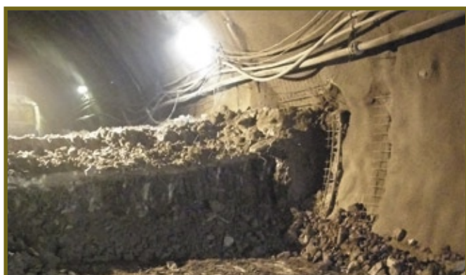
Ryc. 19. Kontynuacja obudowy wstępnej w spągu.
