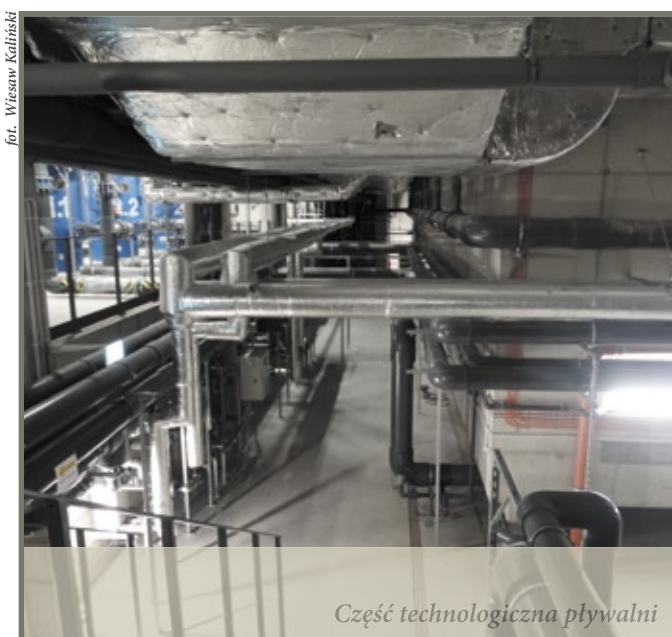
Część technologiczna pływalni
