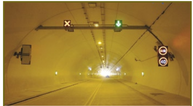
Ryc. 22. Tunel oddany do użytku
