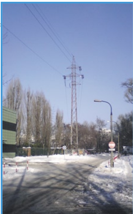
Rys. 5. Napowietrzna linia wysokiego napięcia w Warszawie
