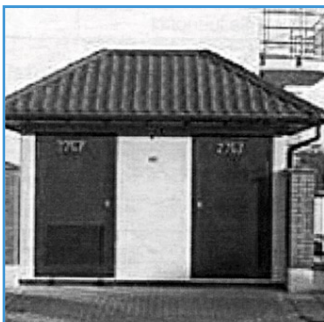
Rys. 9. Osiedlowa kontenerowa stacja transformatorowa [17]
