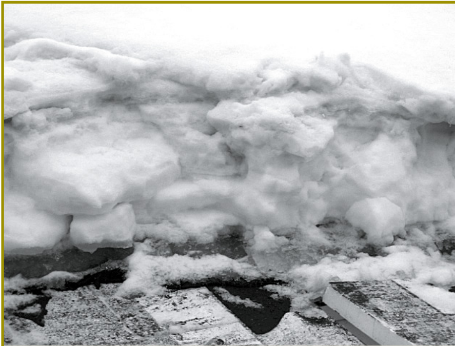
Rys. 3. Pokrywa śnieżno-lodowa udokumentowana na dachu pawilonu nr 1 MTK w 2006 r. [1]
