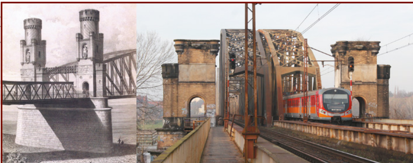
Fot. 11. Filar XII. Rysunek z atlasu do Zeitschrift für Bauwesen z 1876 r. Fot. 12. Most nad podporą nr 12 (23.11.2017)
