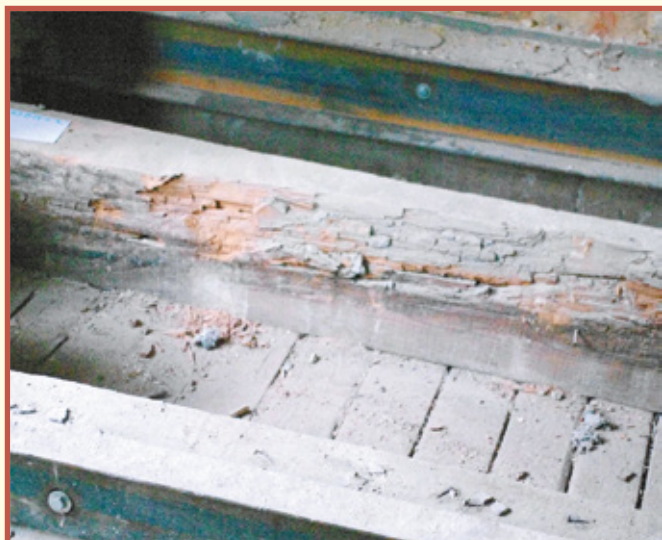
Ryc. 2. Biokorozja belki – strop 2. piętra, sala 2, b25/3. Rozkład brunatny drewna spowodowany przez grzyb domowy właściwy
