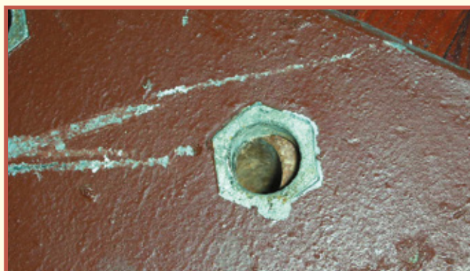
Ryc. 3. Przemieszczenie dźwigara w okuciu stalowym
