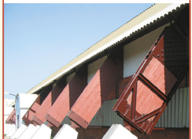
Ryc. 8. Dodatkowe zabezpieczenia stref podpór (wg projektu dr. inż. Marka Sitnickiego)
