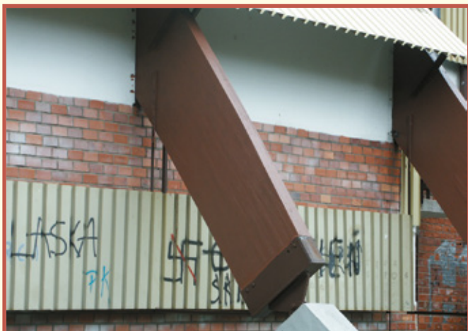
Ryc. 9. Dźwigar po wykonanych pracach konserwacyjnych i zabezpieczających
