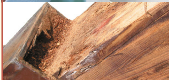
Ryc. 1. Przykłady uszkodzeń korozyjnych
