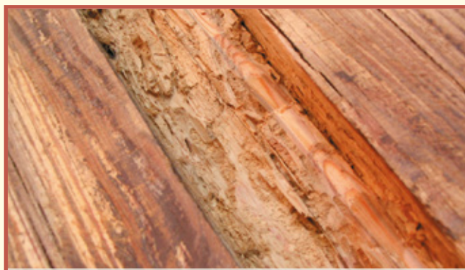
Ryc. 2. Porażony pojedynczy lamel w konstrukcji dźwigara
