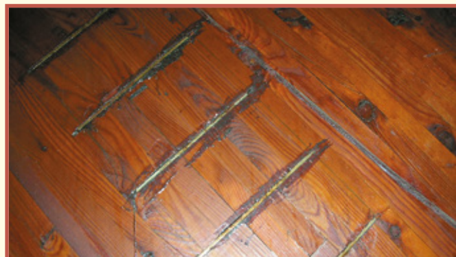
Ryc. 4. Widok połączenia po 35 latach eksploatacji
