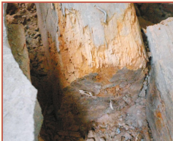
Ryc. 3. Biokorozja belki – strop 1 piętra, sala 7, b11/52. Główka belki zniszczona przez larwy kołatka domowego
