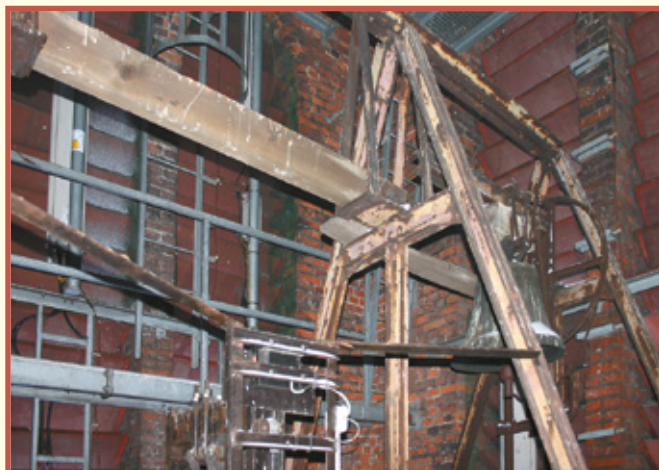
Ryc. 7. Widok stelaża dzwonnicy
