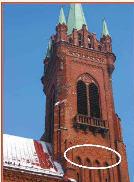
Ryc. 10. Uszkodzenia elewacji wieży od strony południowej. Zakreślono miejsca zmiany materiałów elewacyjnych
