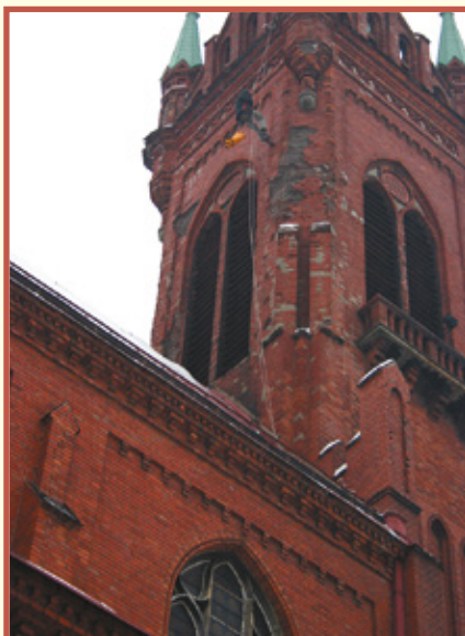
Ryc. 11. Uszkodzenia elewacji wieży od strony zachodniej
