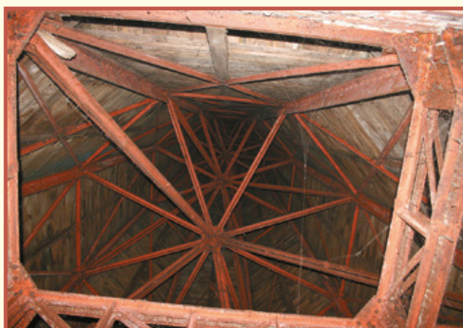
Ryc. 8. Widok konstrukcji stalowej iglicy
