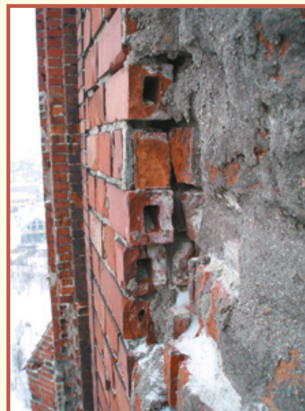
Ryc. 12. Szczegół mocowania elewacji do warstwy nośnej muru
