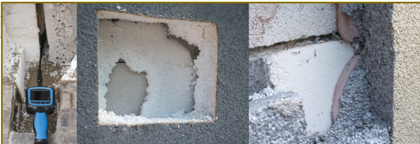
Fot. 4–6. Przyklejenie termoizolacji tylko „na placki” oraz na podklejkach jest bezpośrednim przyczynkiem do jej demontażu
