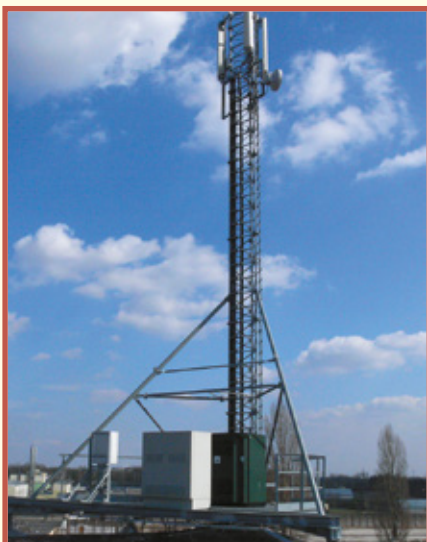
Fot. 3. Wieża usytuowana na dachu budynku
