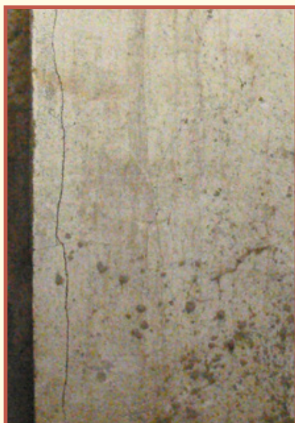
Fot. 6. Zarysowanie dolnej części słupa narożnego usytuowanego pod masztem
