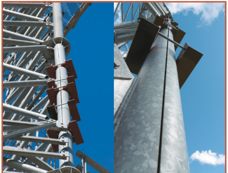
Fot. 2 i 3. Widok pęknięcia rury i obejm tymczasowych
