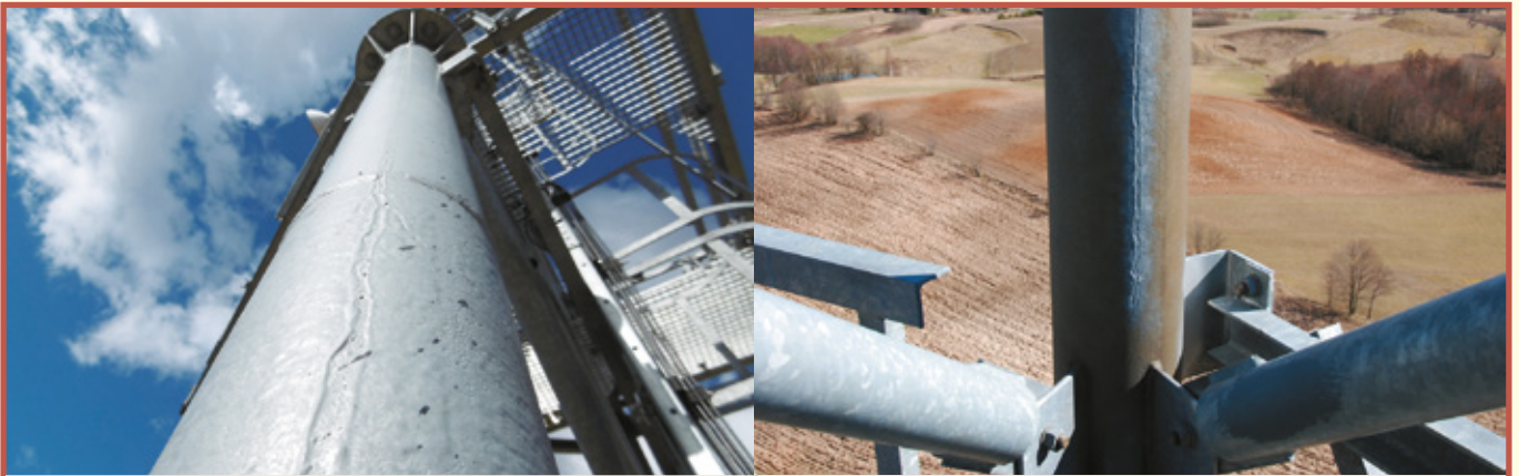
Fot. 8 i 9. Zacieki warstwy ocynku na rurach narożników
