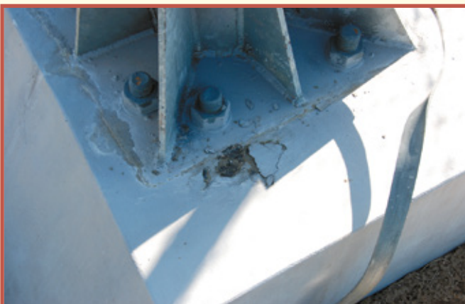
Fot. 10. Odparzona warstwa zaprawy cementowej szczytu stopy fundamentowej wieży
