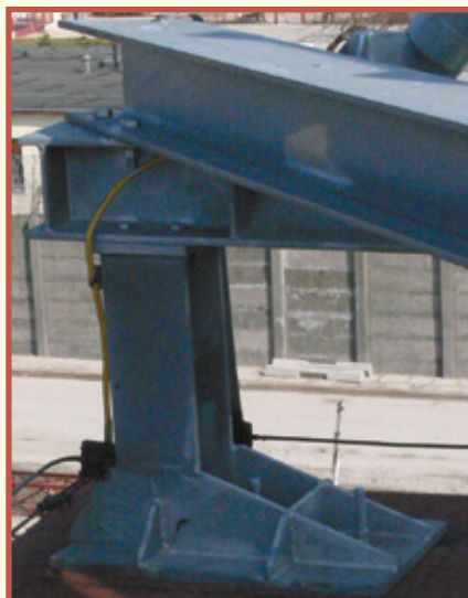
Fot. 4. Szczegół oparcia rusztu na konstrukcji dachu hali
