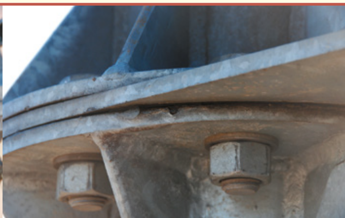
Fot. 6 i 7. Połączenie narożników sąsiednich segmentów wieży – brak zapasu długości śrub, brak podkładek sprężystych w połączeniu, odpryski i uszkodzenia warstwy ocynku, początki korozji powierzchniowej blach, występowanie wody na krawędzi styku blach (dolne zdjęcie)
