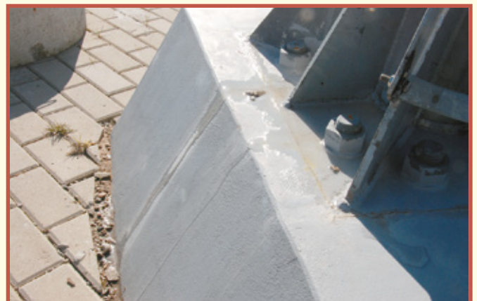
Fot. 11. Wypływanie wody z wnętrza rury najniższego segmentu na styku blachy węzłowej i szczytu stopy fundamentowej, zacieki korozyjne blachy węzłowej
