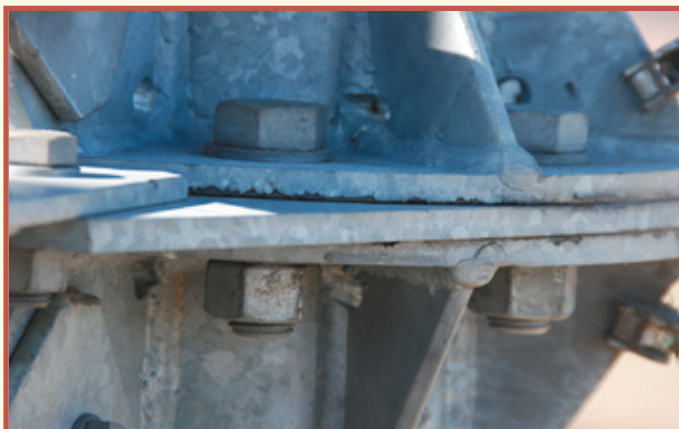
Fot. 6 i 7. Połączenie narożników sąsiednich segmentów wieży – brak zapasu długości śrub, brak podkładek sprężystych w połączeniu, odpryski i uszkodzenia warstwy ocynku, początki korozji powierzchniowej blach, występowanie wody na krawędzi styku blach (dolne zdjęcie)
