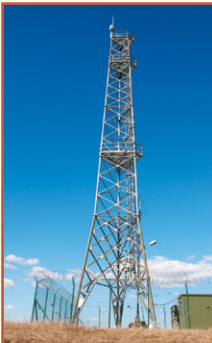
Fot. 1. Widok wieży
