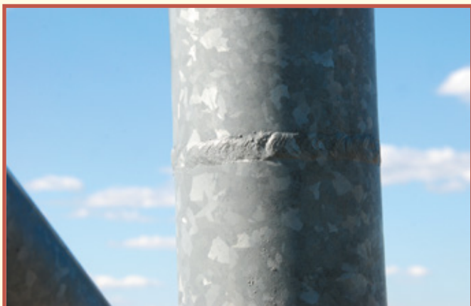
Fot. 4. Łączenie rury segmentu IV z dwóch odcinków spoiną czołową
