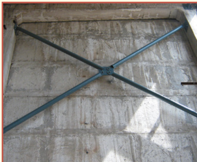
Fot. 8. Usztywnienie dodatkowe ścian poprzecznych
