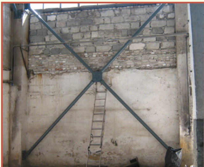
Fot. 7. Usztywnienie dodatkowe ściany podłużnej
