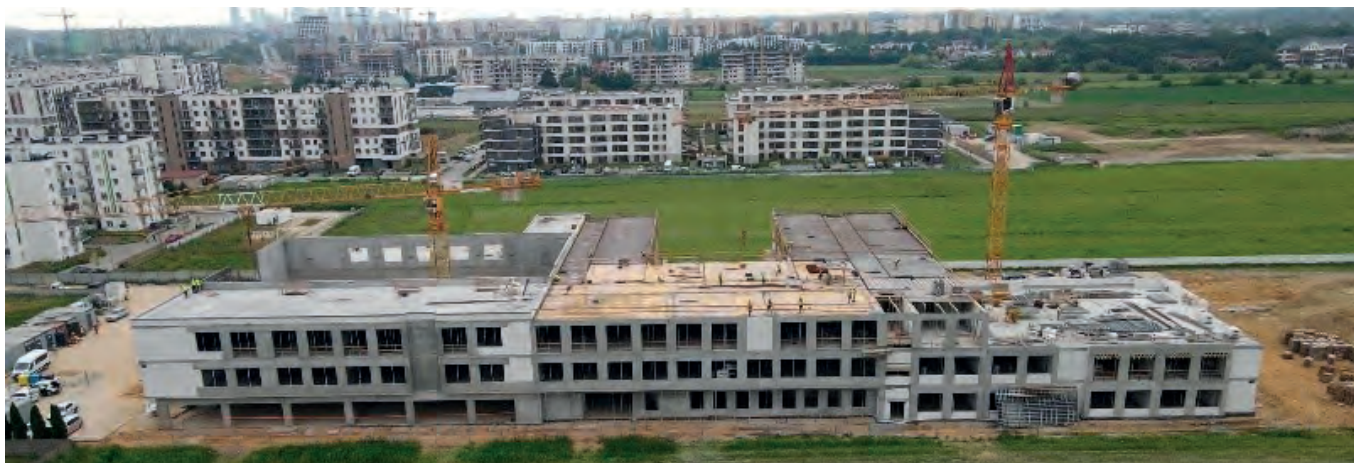
Fot. Budowa szkoły przy ul. Szeligowskiej w Warszawie
