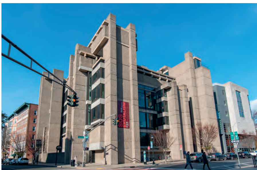
Fot. 2. Widok na fasadę budynku Rudolph Hall
