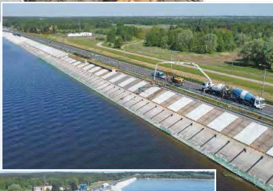
▶ Widok z drona na prowadzone betonowanie płyt parzystych I rzędu płyt - prawa strona zapory
