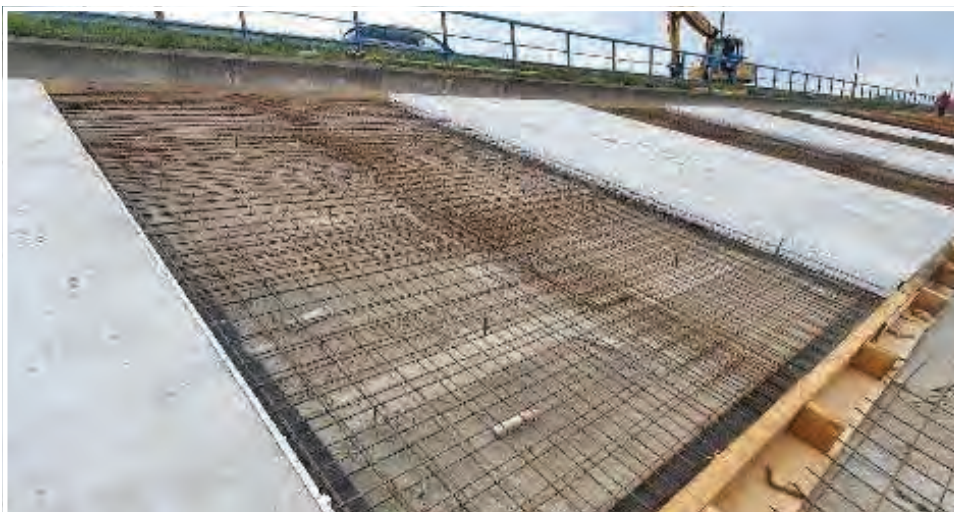
◀ Widok na zamontowane zbrojenie płyty parzystej
