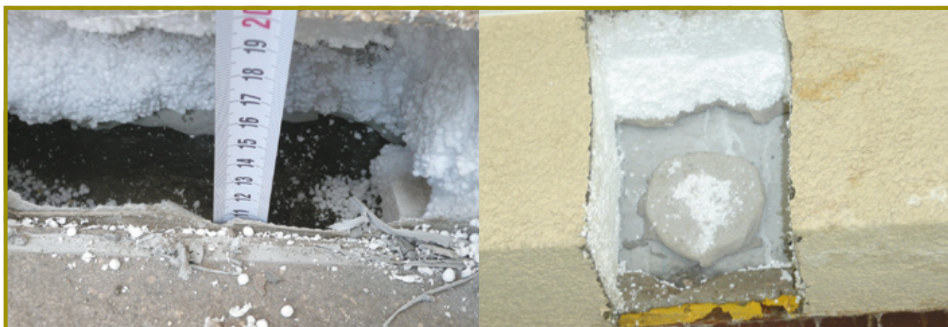
Fot. 12–13. Błędy w termoizolacji styku połączenia balkonów ze ścianą to przyczyna pojawienia się skroplin wypływających spod ościeży
