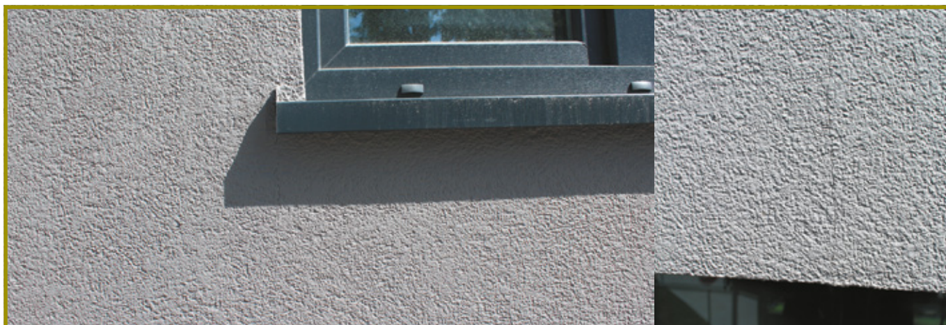
Fot. 9–10. Zarysowania powstałe na skutek niestabilnego podłoża. Wykonawca podjął próbę naprawy (nieskuteczną)
