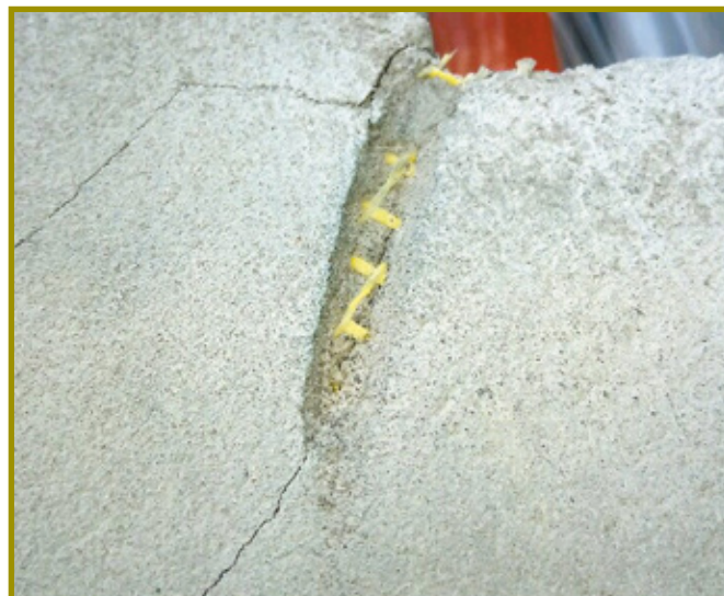
Fot. 7. Rysa w narożniku pomimo obecności siatki diagonalnej
