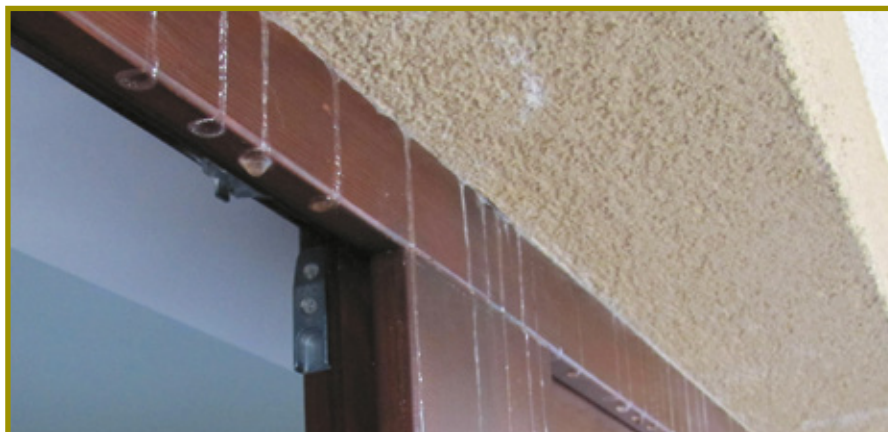
Fot. 11. Skropliny wypływające spod ościeży okiennych. Cechą szczególną było to, że problem pojawiał się jedynie w drzwiach i oknach pod balkonami wspornikowymi ocieplanymi obustronnie. Przyczyną nie były przecieki
