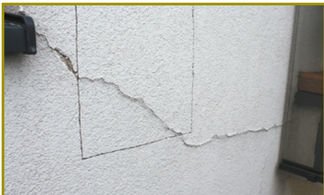
Fot. 4. Typowa rysa sugerująca brak siatek diagonalnych w narożu otworu okiennego. Widoczne miejsce wykonania odkrywki. W dalszym etapie odkrywka została poszerzona w stronę parapetu
