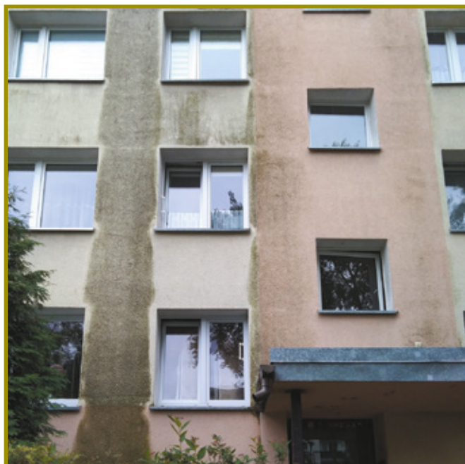
Fot. 3. Tak zaawansowane porażenie biologiczne zwykle ma „drugie dno” związane z brakiem analizy cieplno-wilgotnościowej
