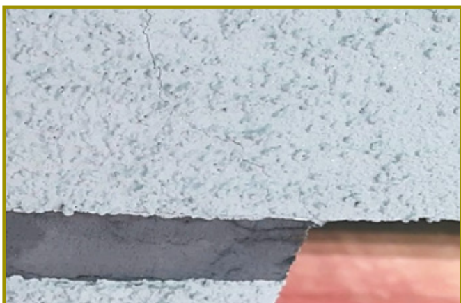
Fot. 8a. Kolejny przykład rysy, której geometria zdaje się sugerować, że jej powodem może być brak siatek diagonalnych
