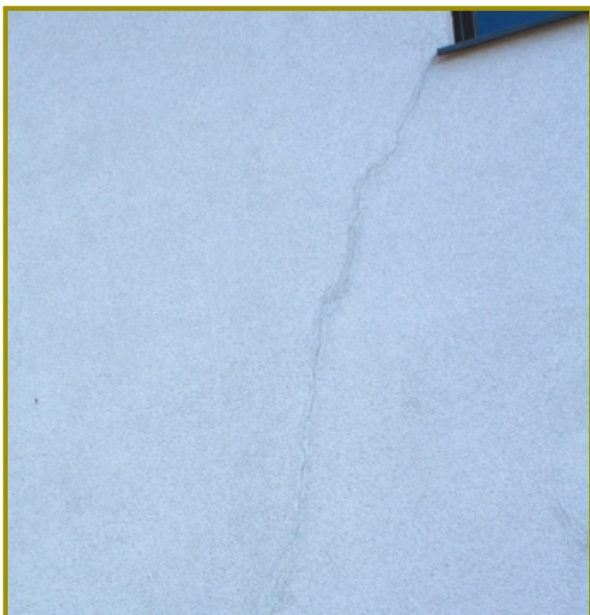
Fot. 5a. Geometria rysy zdaje się sugerować, że jej powodem może być brak siatek diagonalnych
