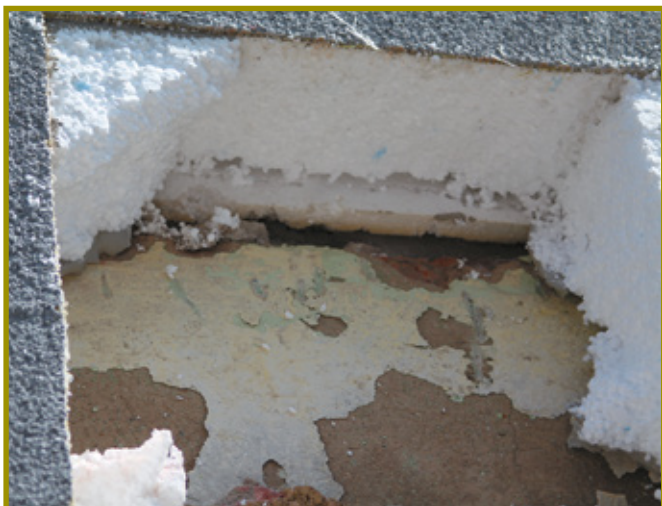
Fot. 6. Odkrywka w miejscu zmiany kierunku zarysowania. Obecność niestabilnego podłoża, zmiana rodzaju podłoża i podklejki to przyczyny rysy poziomej. Błędy te jednocześnie uniemożliwiają lokalną naprawę rysy
