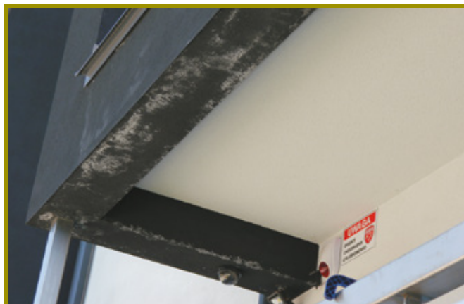
Fot. 1. Ustalenie przyczyn niektórych uszkodzeń systemów ETICS wymaga wykonania bardzo szczegółowej analizy cieplno-wilgotnościowej
