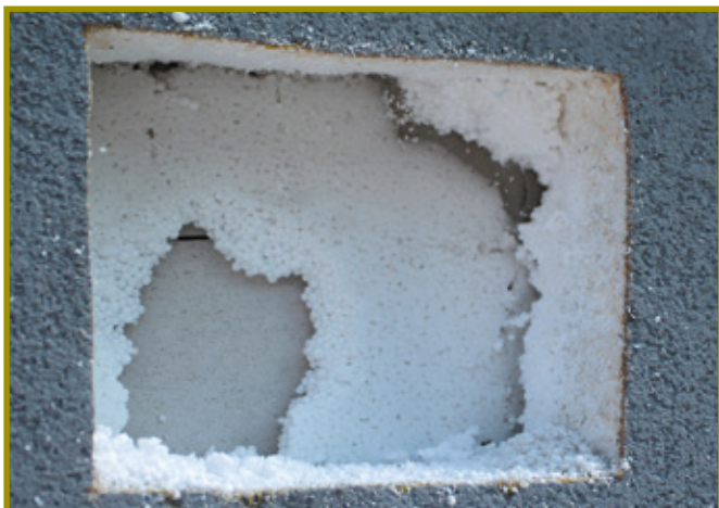
Fot. 5b. Przyczyna, dla której naprawa samego zarysowania jest niemożliwa
