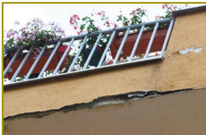
Fot. 2. Destrukcja systemu ETICS bezpośrednio związana z błędami w wykonaniu balkonów
