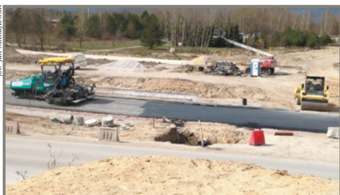
Fot. 5. Układanie warstw nawierzchni ulicy Maratońskiej w nowym śladzie obok istniejącej jezdni
