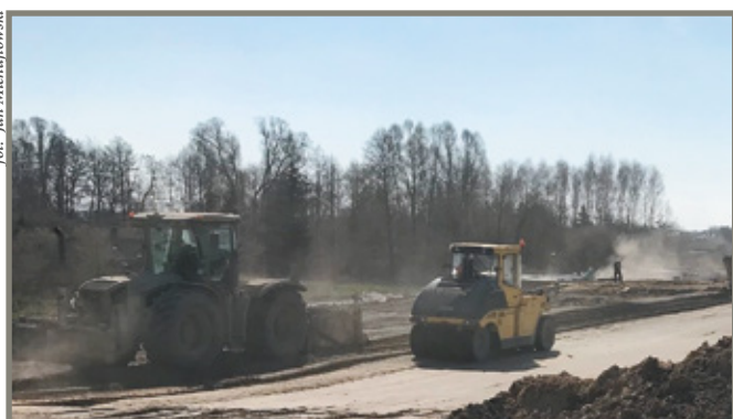
Fot. 7. Rozkładanie i zagęszczanie warstwy gruntu z cementem
