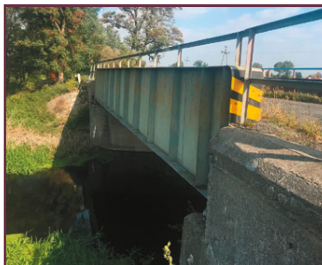
Ryc. 2. Most blachownicowy w Retkach
