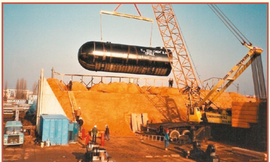
Fot. 7. Gotowy cały nasyp budowlany do posadowienia na nim zbiornika gazu płynnego oraz połowa cylindra zbiornika podczas montażu na nasypie
