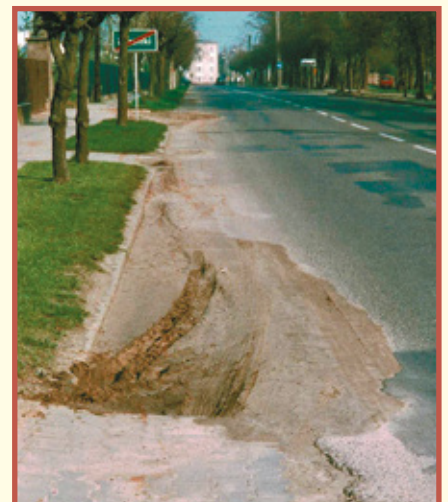
Fot. 11. Zamulenie nawierzchni drogi krajowej na granicy miasta Warty i miejscowości Duszniki
