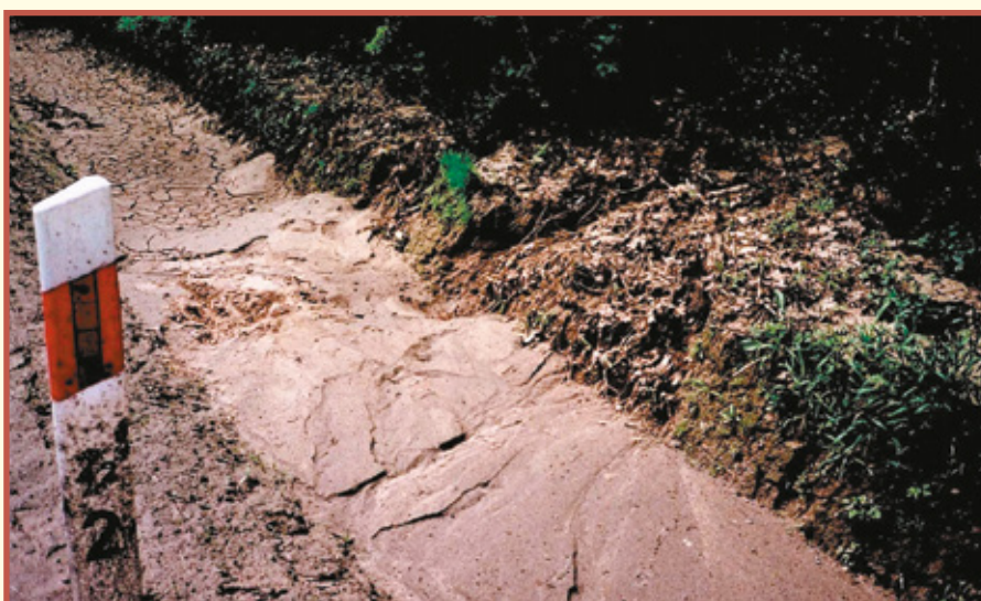
Fot. 9. Zamulony rów zachodni. Widoczne miejsca spływu zmywów z pól poprzez zalesione zbocze
