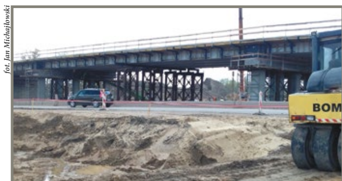
Ryc. 3. Wiadukt WD17 z odcinkiem starej trasy DK71 (ul. Aleksandrowska w Zgierzu)
