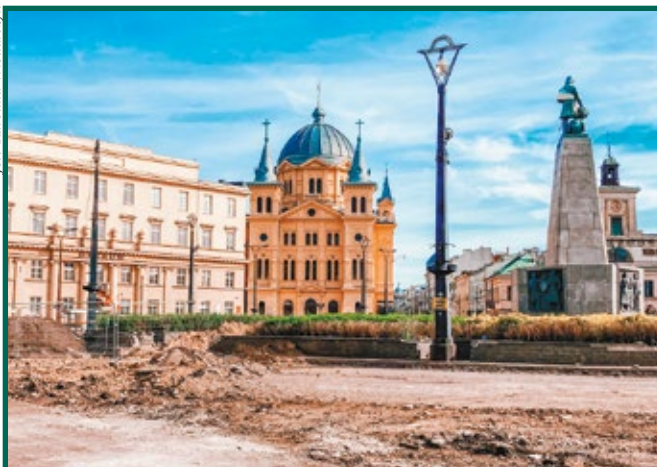
Plac Wolności dzisiaj w trakcie przebudowy
