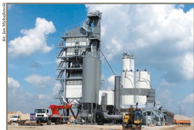
Ryc. 5. Wytwórnia mas asfaltowych na potrzeby budowy
