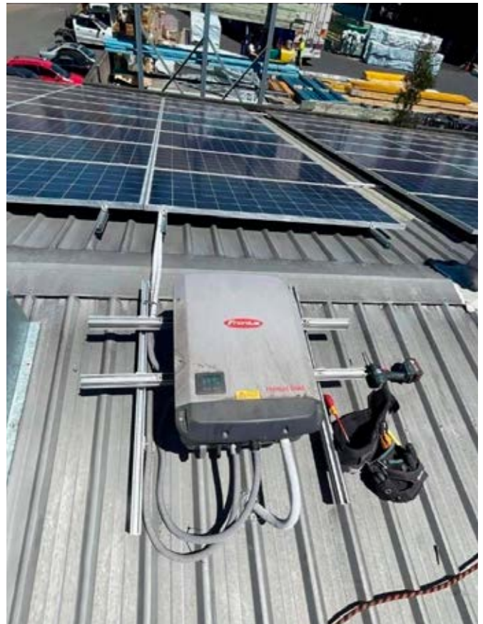
Ryc. 12. Niepoprawny montaż inwertera na dachu
