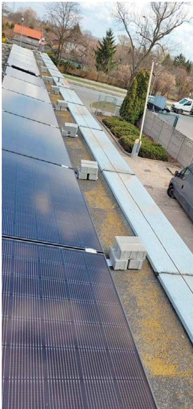
Ryc. 4. Niepoprawnie obciążona instalacja PV
