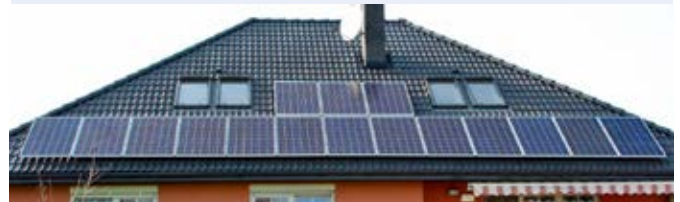
Ryc. 2. Instalacja zamontowana zbyt blisko krawędzi dachu
