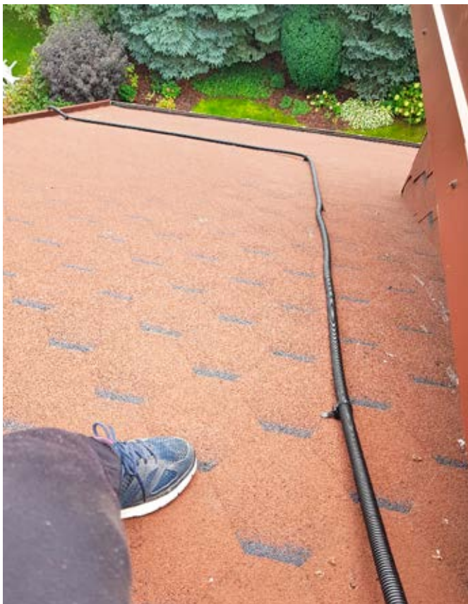
Ryc. 6. Kabel poprowadzony bezpośrednio na łatwopalnym pokryciu dachu
