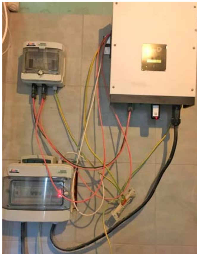
Ryc. 7. Brak odpowiedniego zabezpieczenia przewodów
