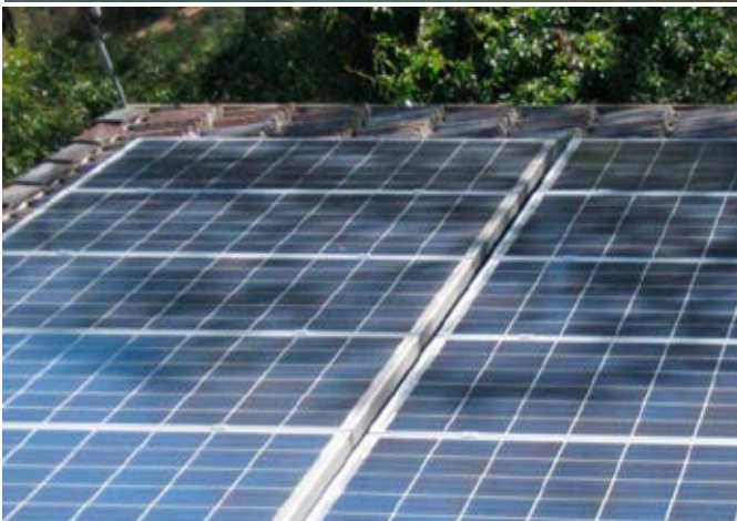
Ryc. 3. Zacięnienie instalacji fotowoltaicznej
