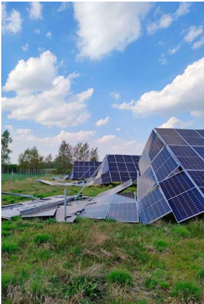
Ryc. 5. Uszkodzenie instalacji fotowoltaicznej spowodowane złym doborem konstrukcji
