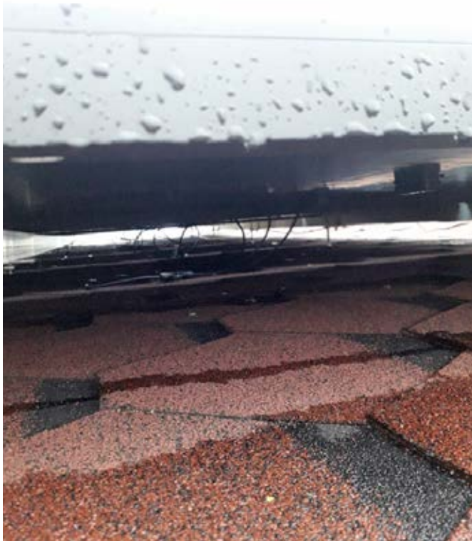
Ryc. 11. Zdjęcie ilustrujące błędnie zamontowaną instalację – kable nie są odpowiednio upięte, wiszą na łatwopalnym pokryciu dachu
