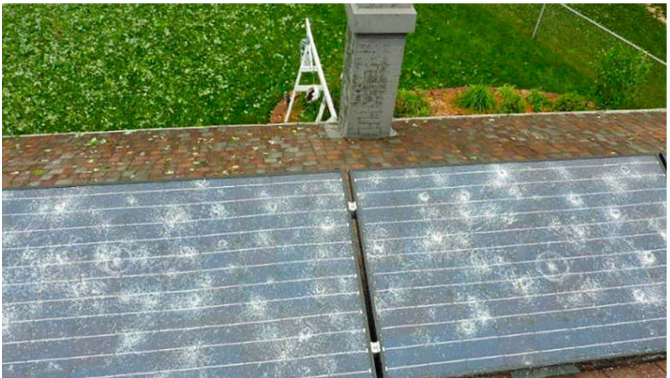
Ryc. 14. Panel uszkodzony przez gradobicie
