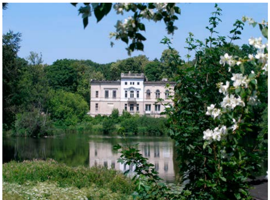
Fot. 4. Pałac Ludwika Heinzla w Łągiewnikach (2006 r.)
