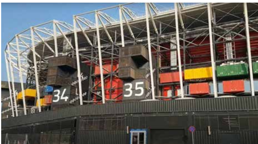
Pierwszy mobilny stadion piłkarski zbudowany z kontenerów fot. swiat-kontenerow.pl
