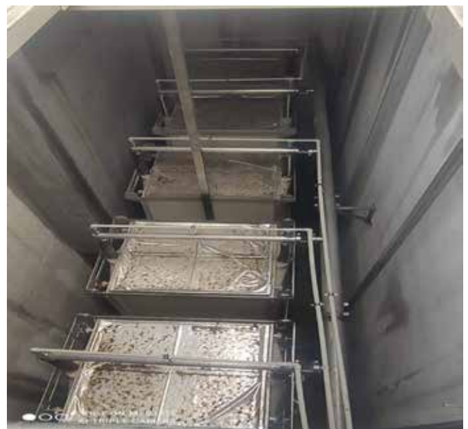
Ryc. 5. Moduły membranowe mikrofiltracyjne zastępujące tradycyjne osadniki wtórne (materiał udostępniony przez firmę Schwander Polska)
