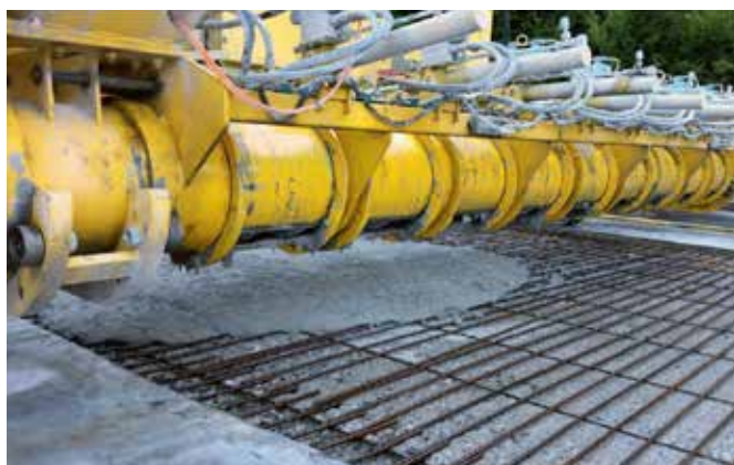
Rys. 16. Mechaniczne układanie mieszanki Ductalu
