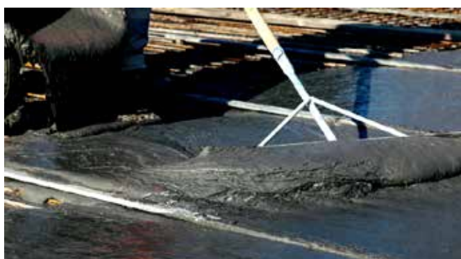
Rys. 17. Ręczne układanie mieszanki stosowanej przy wzmacnianiu stropów
