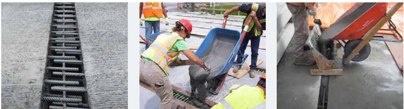
Rys. 19. Wykonywanie złączy prefabrykowanych płyt pomostowych: a) widok złącza przed betonowaniem, b) i c) wypełnianie złącza UHPC
