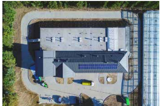
Ryc. 4. Oczyszczalnia ścieków w miejscowości Kunów (woj. świętokrzyskie) wykorzystująca zamiast osadników wtórnych moduły membranowe do mikrofiltracji (źródło: www.schwander.pl )
