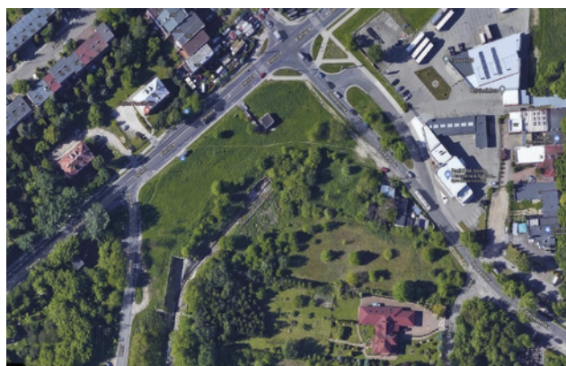
Rys. 2. Widok terenu nad omawianym odcinkiem kanału rzeki Karolewki
