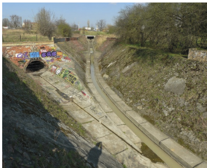
Rys. 3. Widok otwartego koryta rzeki Karolewki na odcinku od wylotu przy ul. Dennej do kolektora przelewowego
