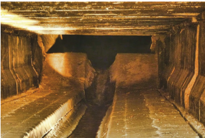
Rys. 4. Widok elementów kanału rzeki Karolewki od jego wnętrza
