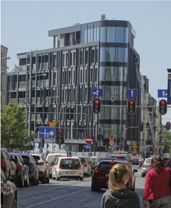
Budowa apartamentowca, fot. Wiesław Kaliński
