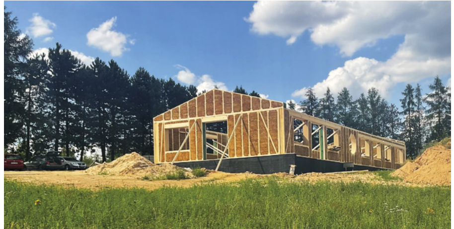
Fot. 2. Przykładowy budynek wzniesiony w technologii paneli słomiano-drewnianych. [7]
