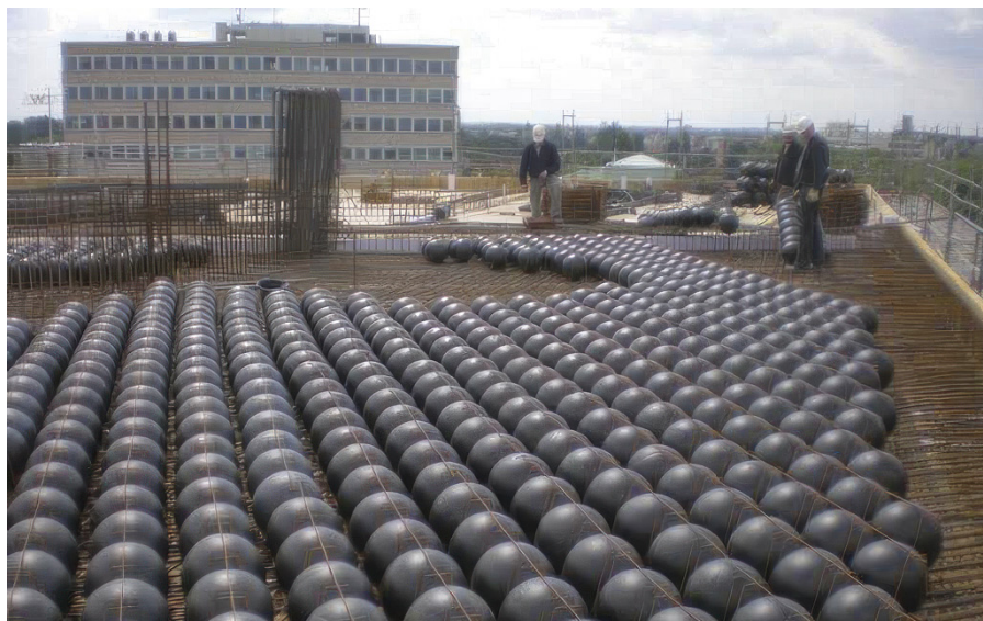
Rys. 2. Szczegół stropu Cobiax [6]
