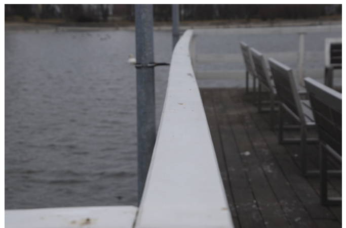
Fot. 5. Wygięcia w płaszczyźnie poziomej belek i bariery pokładu górnego części równoległej do linii brzegowej pomostu Fot. Dariusz Zaręba
