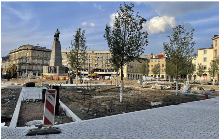
Układanie kostki granitowej. Fot. Radiolodz.pl
